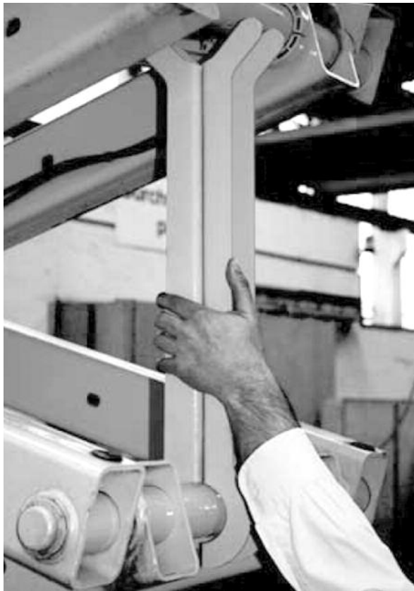
Instalación de soporte para comenzar con las tareas de mantenimiento en un elevador de tijera hidráulico.
